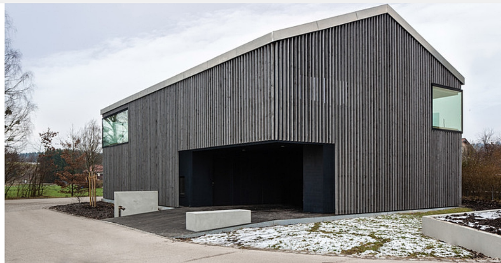
Architekturbüro Gassner & Zarecky, Riemerling: Haus ET 35 in Moosach
