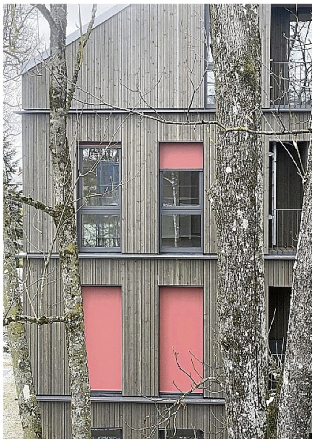
Vier Wohnhäuser in der Luitpoldsiedlung in Hohenbrunn: Die Architekten Tina Frank und Jochen Friker stellen am Samstag, 28. Juni, den Neubau in Holz-Hybrid-Bauweise mit Fertigteilbetondecken vor.
